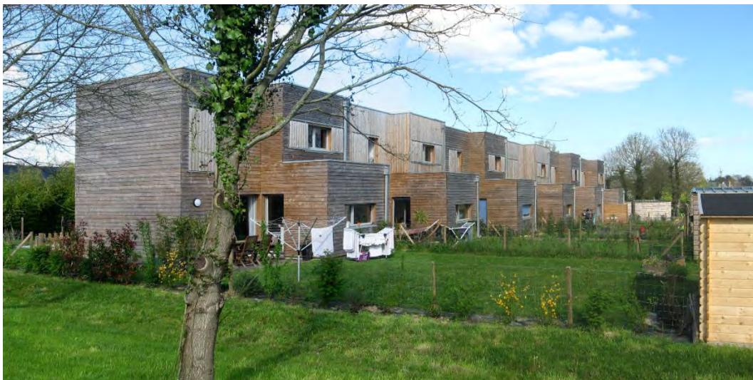
Figure 39 : Exemples de maisons mitoyennes dans l'agglomération rennaise avec des matériaux biosourcés
