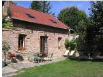
Maison / Logement individuel
