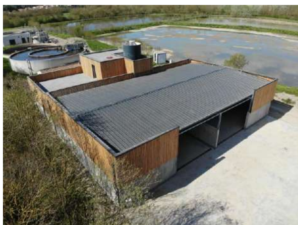
Stockage des boues - STEP Longeville sur Mer
