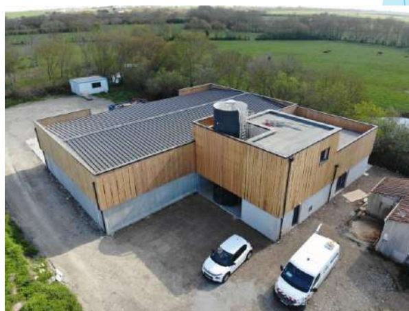
Stockage des boues - STEP Longeville sur Mer
